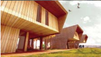
Collège Jean Moulin, © Leilli Architectes
